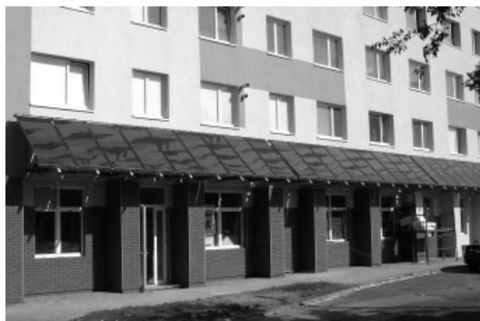
7.2. fotó: Nem minősített, de passzív panelház lett a felújítás után az épületből
