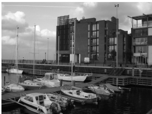
13.2. fotó: Malmö, napkollektorok és áramtermelő napelemek a színes homlokzat lényeges elemei
