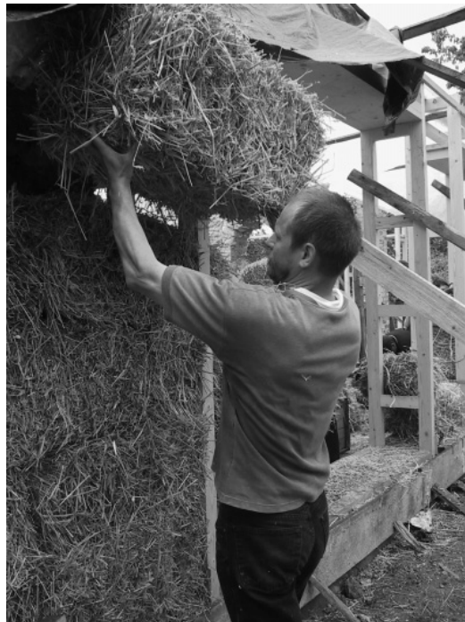
4. fotó: Szalmabála-ház, építés közben 1.
