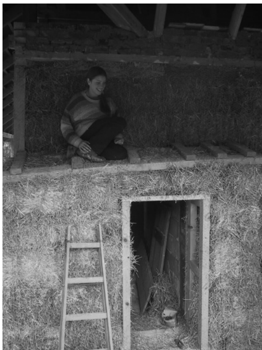
5. fotó: Szalmabála-ház, építés közben 2.,
