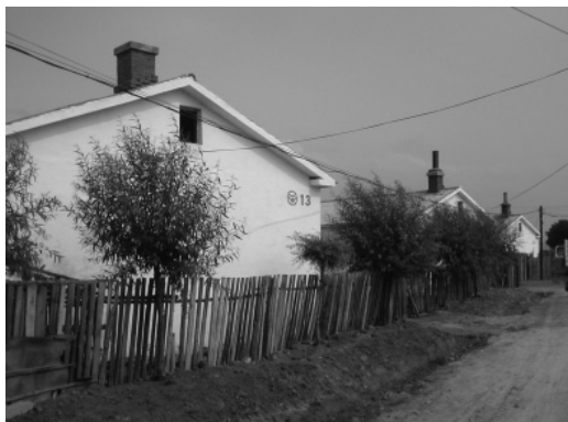
11.1. fotó: Ökofalu egyik épülete építés közben
