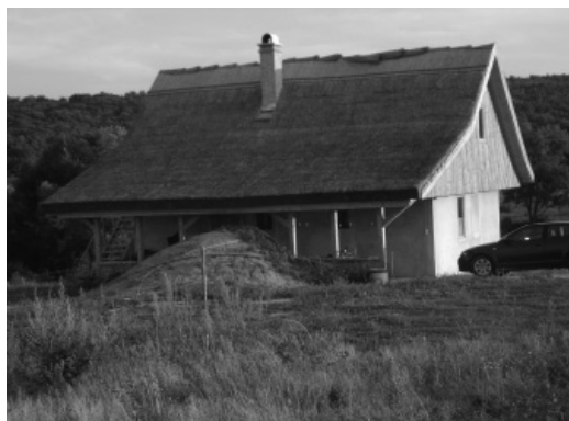
12.2. fotó: Galgahévíz: már átadott és lakott épületek egyike
